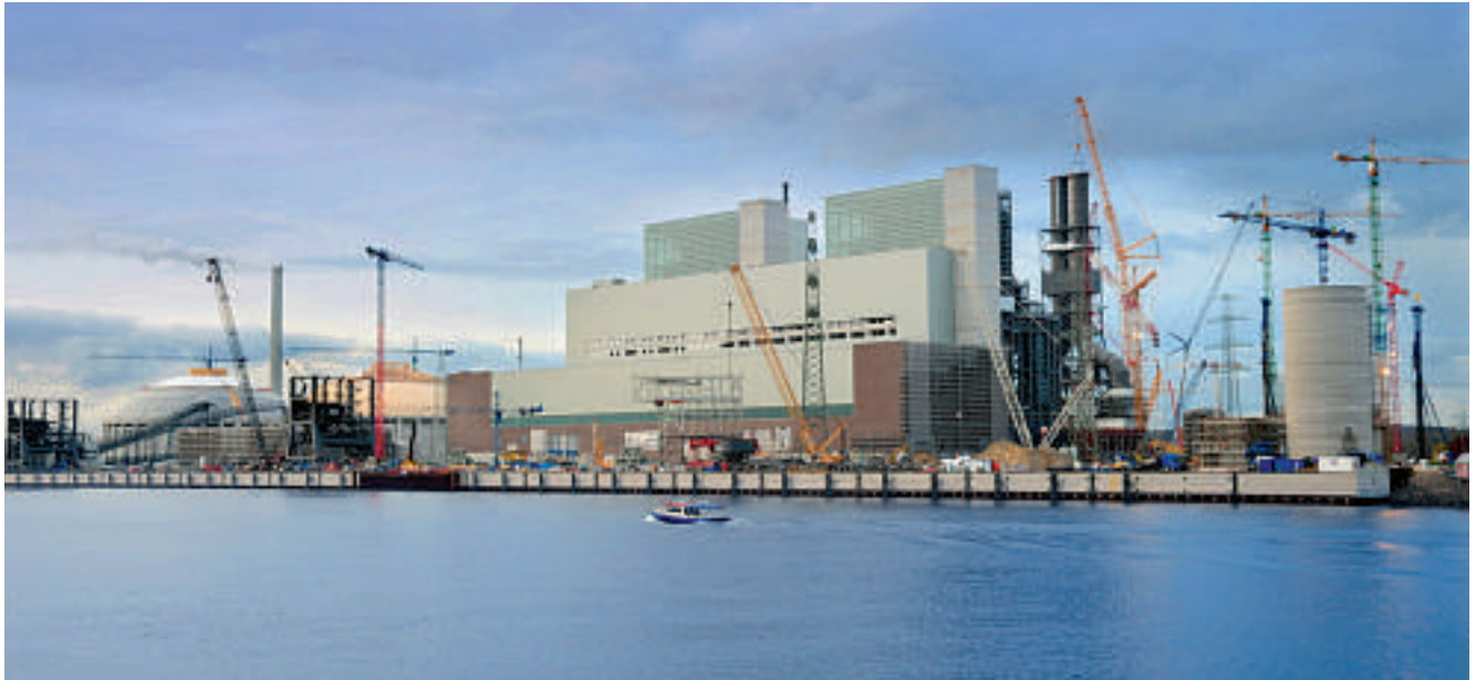
▲ Kraftwerk Moorburg, Bautenstand 2011
