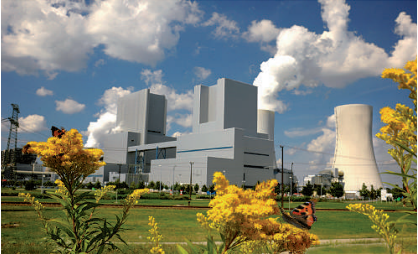
▲ Kraftwerk Boxberg Block R, Bautenstand 2011
