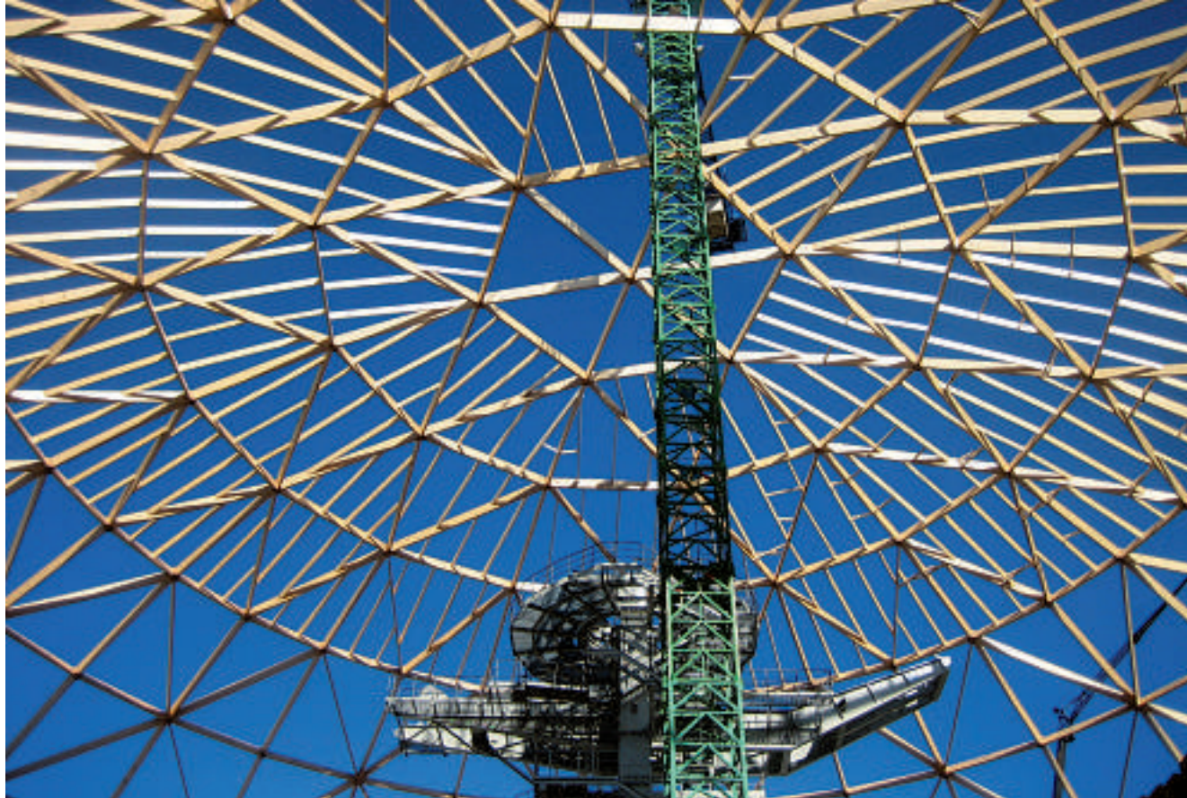
▲ Kraftwerk Moorburg, Dachtragwerk Kohlekreislager
