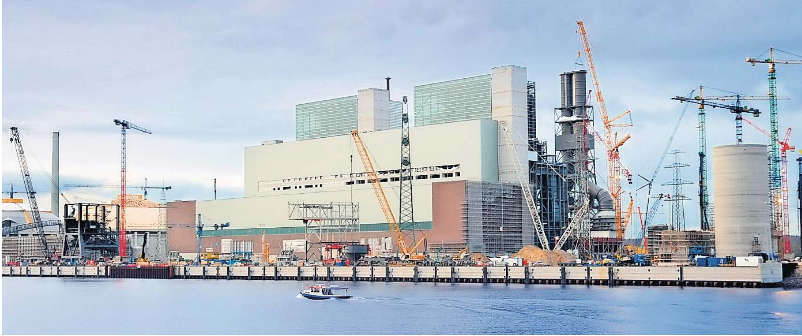
Eines von zahlreichen ARCUS-Projekten ist das Kraftwerk Hamburg-Moorburg.
