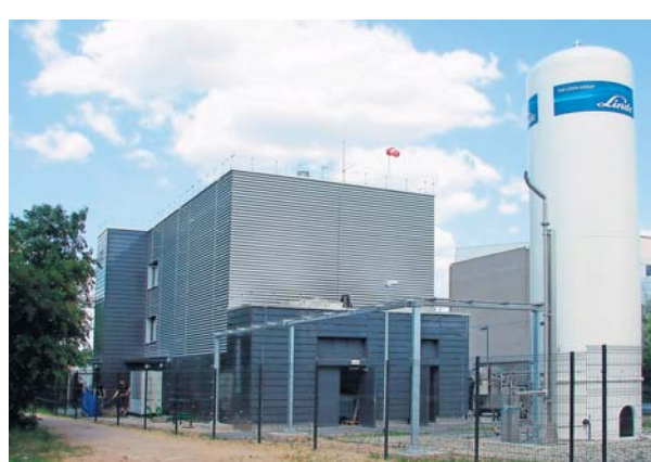
Ein Blick auf die H2-Versuchsanlage Cottbus.
