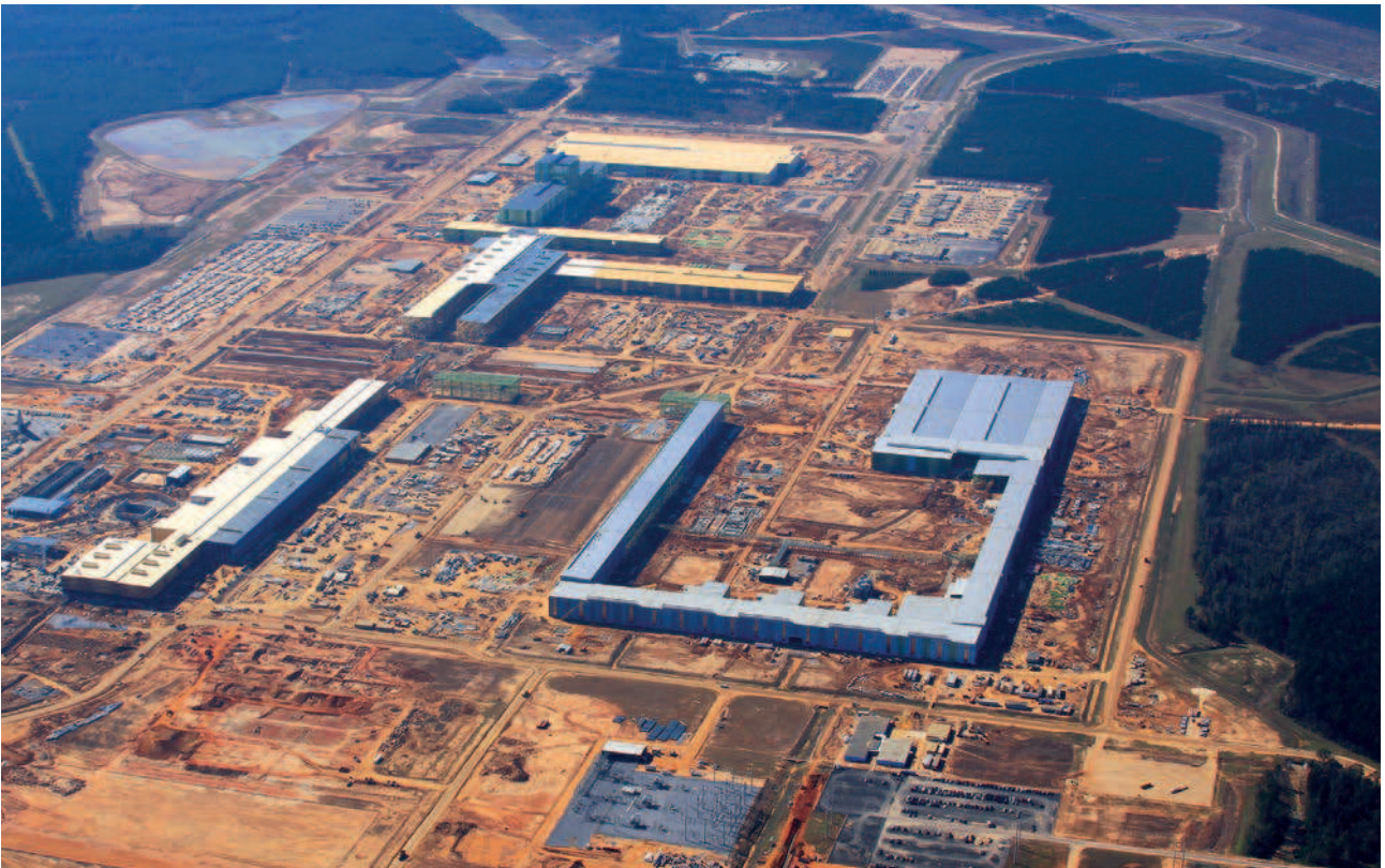
In der Vogelperspektive wird die Dimension des Vorhabens in Alabama deutlich. Bautenstand 2009 Quelle: TKSE
