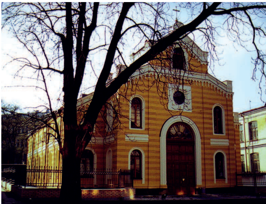
St. Katharinenkirche in Kiev: Seilzug und Muskelkraft, Schubkarre und Eimer mussten für ein modernes Kirchen- und Begegnungszentrum erhalten
