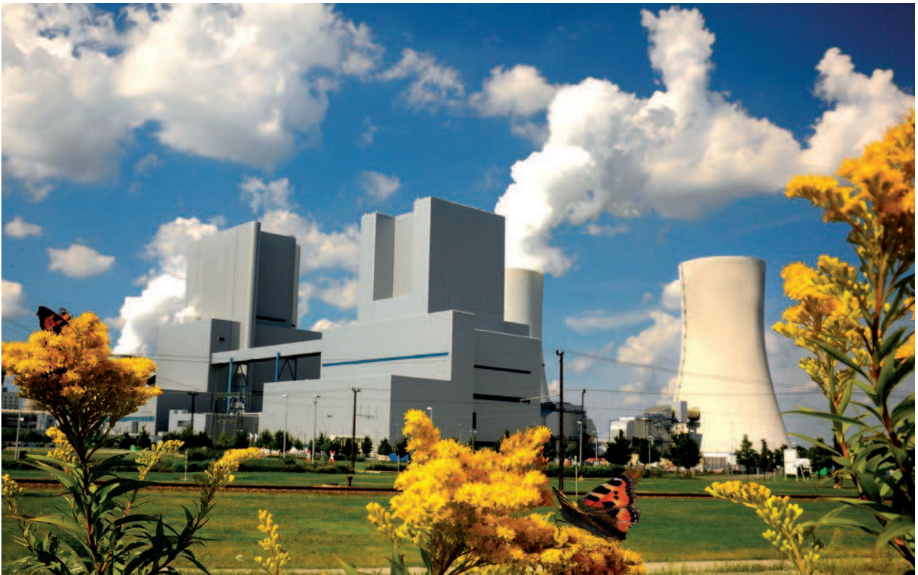
Kraftwerksblock „BoxR“ mit einem Nettowirkungsgrad von 44 Prozent
