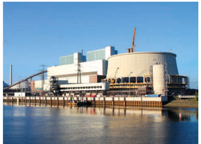
Ansicht Kraftwerk Hamburg-Moorburg von der Süderelbe mit Hauptkaianlage
