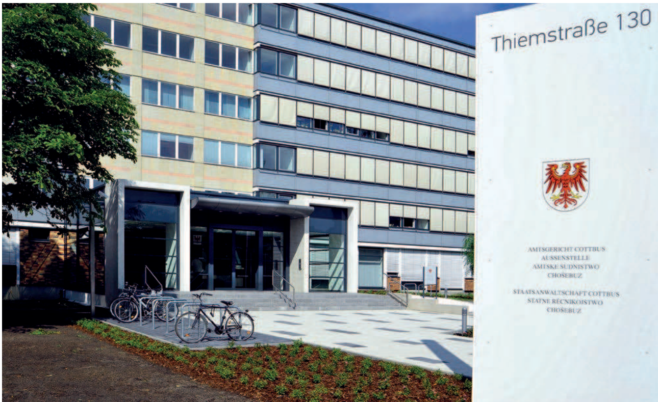
Cottbuser Justizzentrum / Das Hubdeckenverfahren wurde in den USA entwickelt und ist als „Lift-Slab-Methode“ bekannt
